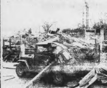
La fuerza del huracán Joan derribó un poste del tendido eléctrico en una calle de Bluefields, dando lugar a que a su vez este partiera y se quedara a la orilla de una vivienda. (Mejía).
