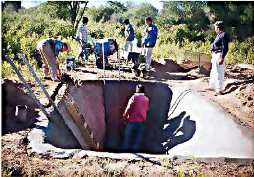
Fotografía 8. Construcción de aljibe revestido con concreto. Fuente: Cajina (6)
