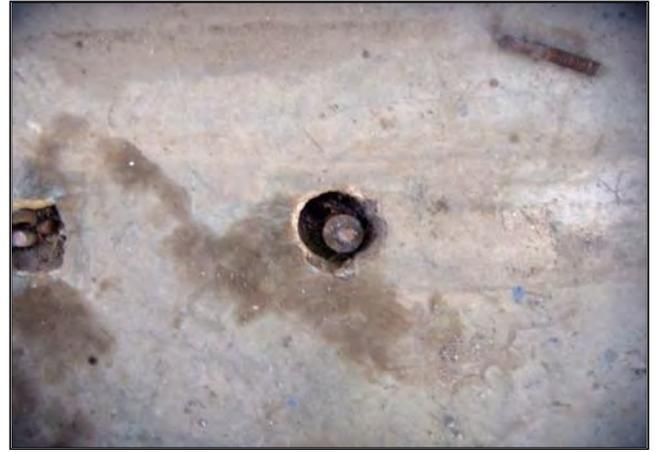
**Daños al piso causados por los motores.**
